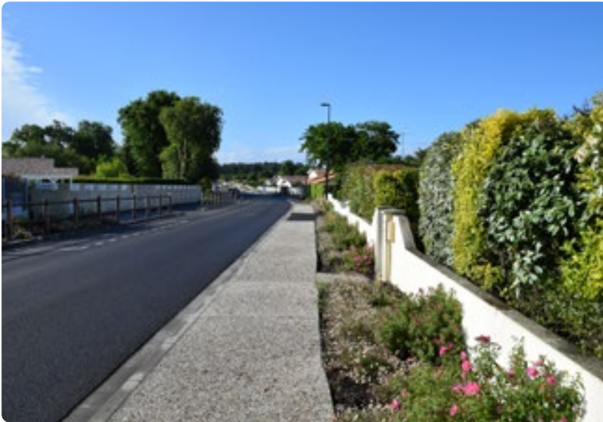
Trottoir en béton désactivé, La Teste de Buch
