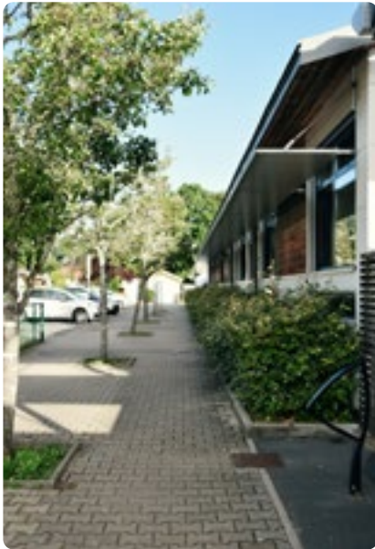
Trottoir en pavés, école Lafon, Cazaux
